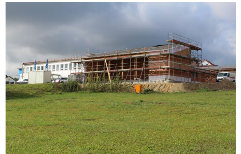
Der Erweiterungsbau für das Informationszentrum zur Trinkwasserversorgung und zum Grundwasserschutz in Pattendorf – ein LEADER-Projekt – macht gute Fortschritte.
